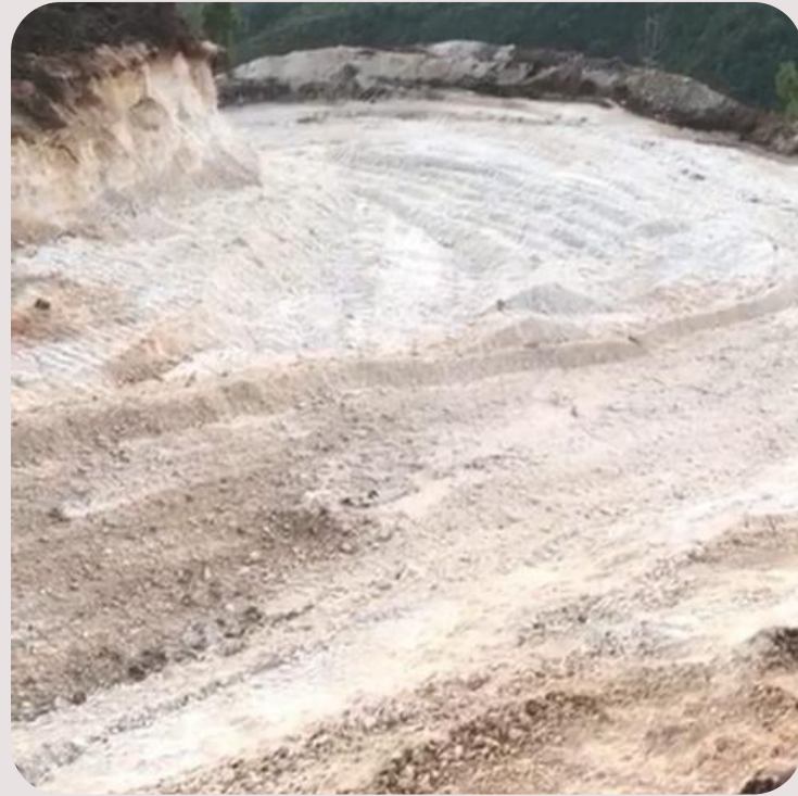
MANTENIMIENTO CAMINOS EL BARRO
