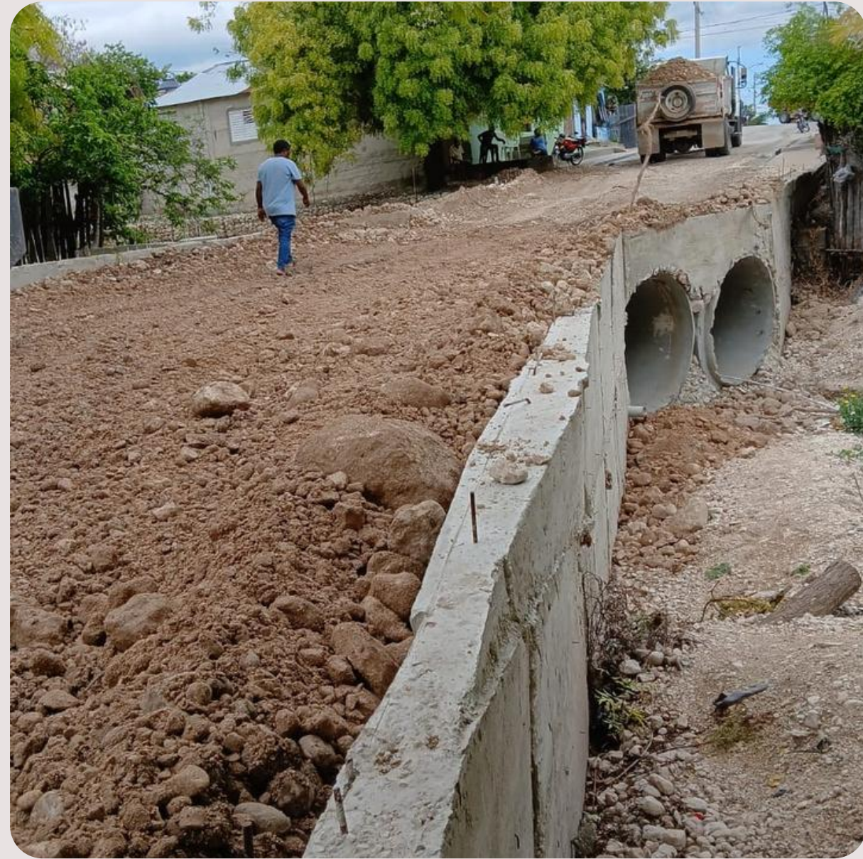
CONSTRUCCION PUENTE 30 MARZO, ALTO VELO
